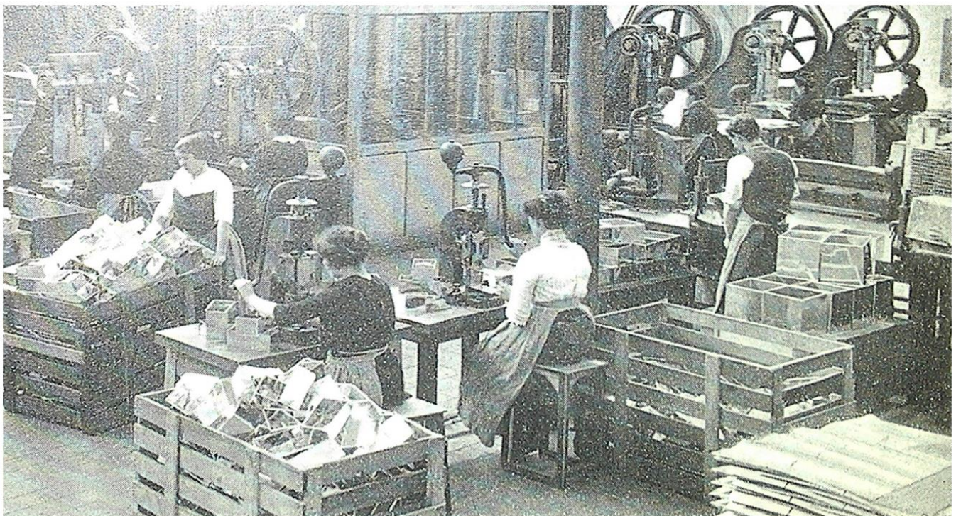
FERBLANTERIE. — Machines à confectionner les boîtes fer-blanc.
