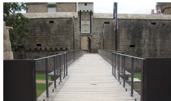
5 - Accès à la cour (rampe à droite du porche)
